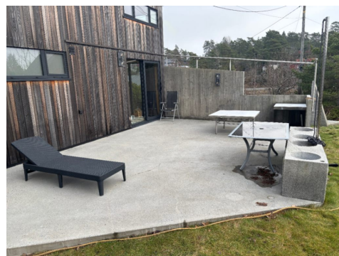
Viser støpt terrasse
