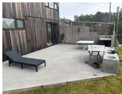
Viser støpt terrasse
