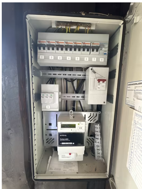
Kabel til elbillader er ikke festet.
