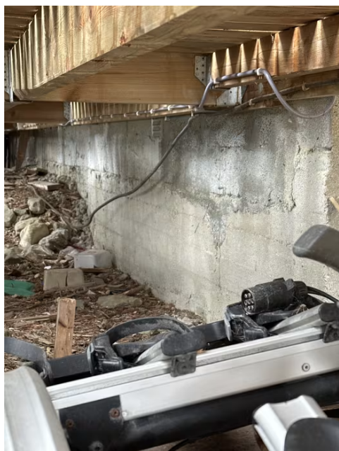
Kabel til elbillader er ikke festet.
