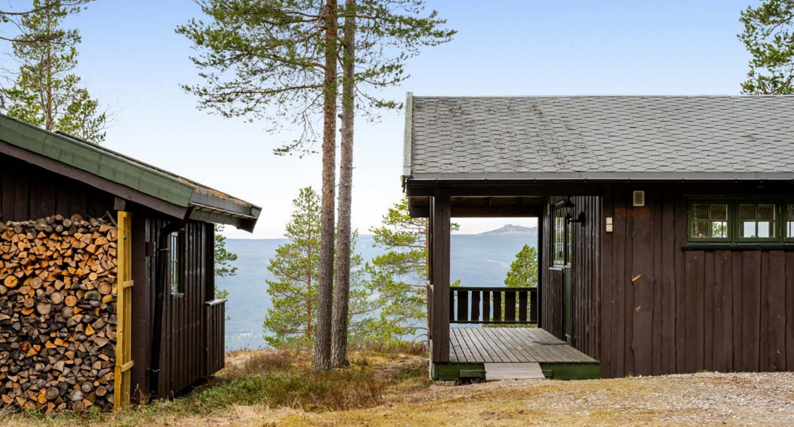
Biloppstillingsplasser til 3 biler på gruset gårdsplass. Det er montert elbil-lader på hytteveggen.
