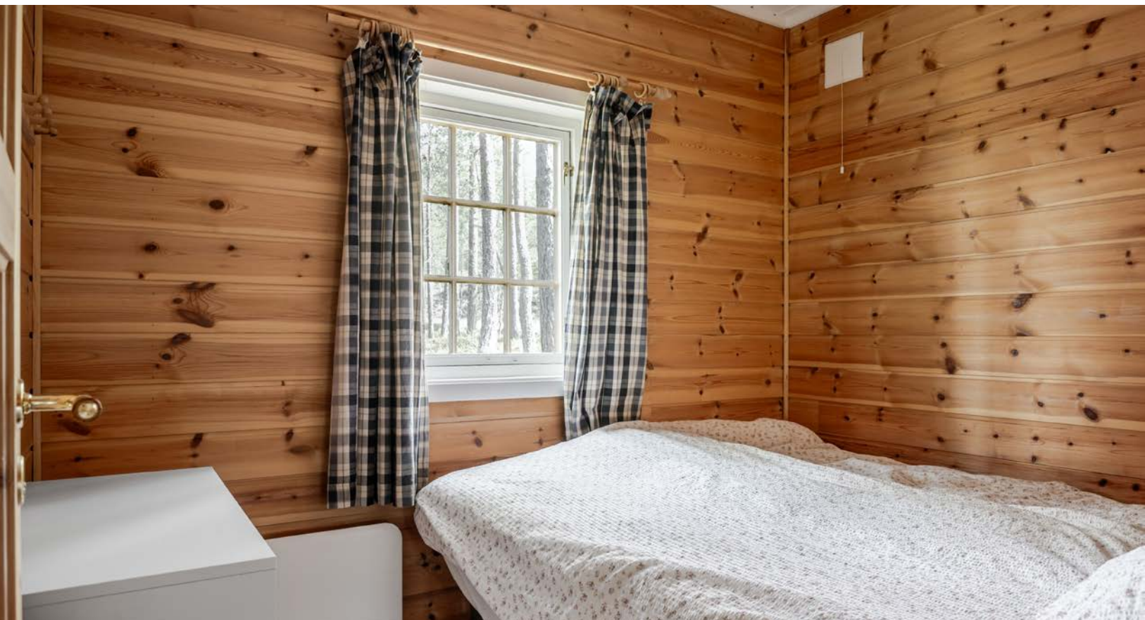
Det er montert panelovner med styring. Selger opplyser at strømforbruket gikk vesentlig ned etter at de monterte nye digitalt styrte panelovner.
