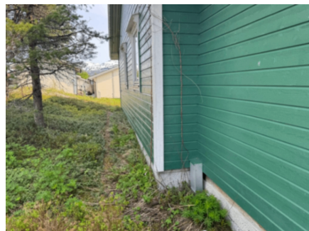
Lettklinkerblokken er ikke pusset.
