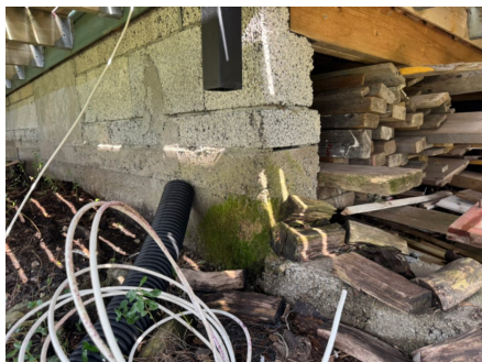
Eksempel på nedløp som er avslutte ved grunnmuren.
