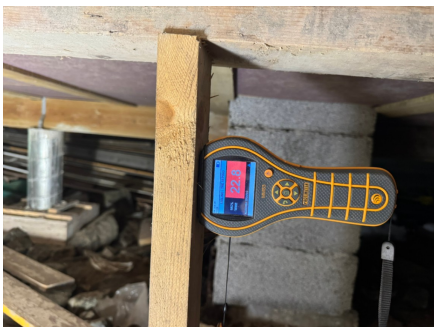
Fuktmåling i provisorisk understøtte.
