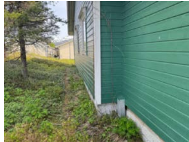
Lettklinkerblokken er ikke pusset.
