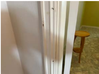
Eksempel på spiker som ikke er spikret helt inn.
