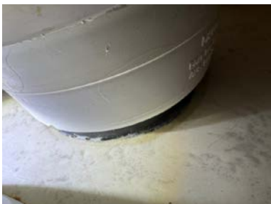
Eksempel på utettheter rundt rørgjennomføring.
