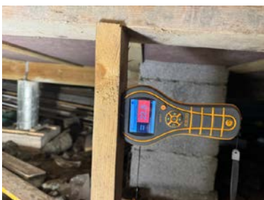
Fuktmåling i provisorisk understøtte.
