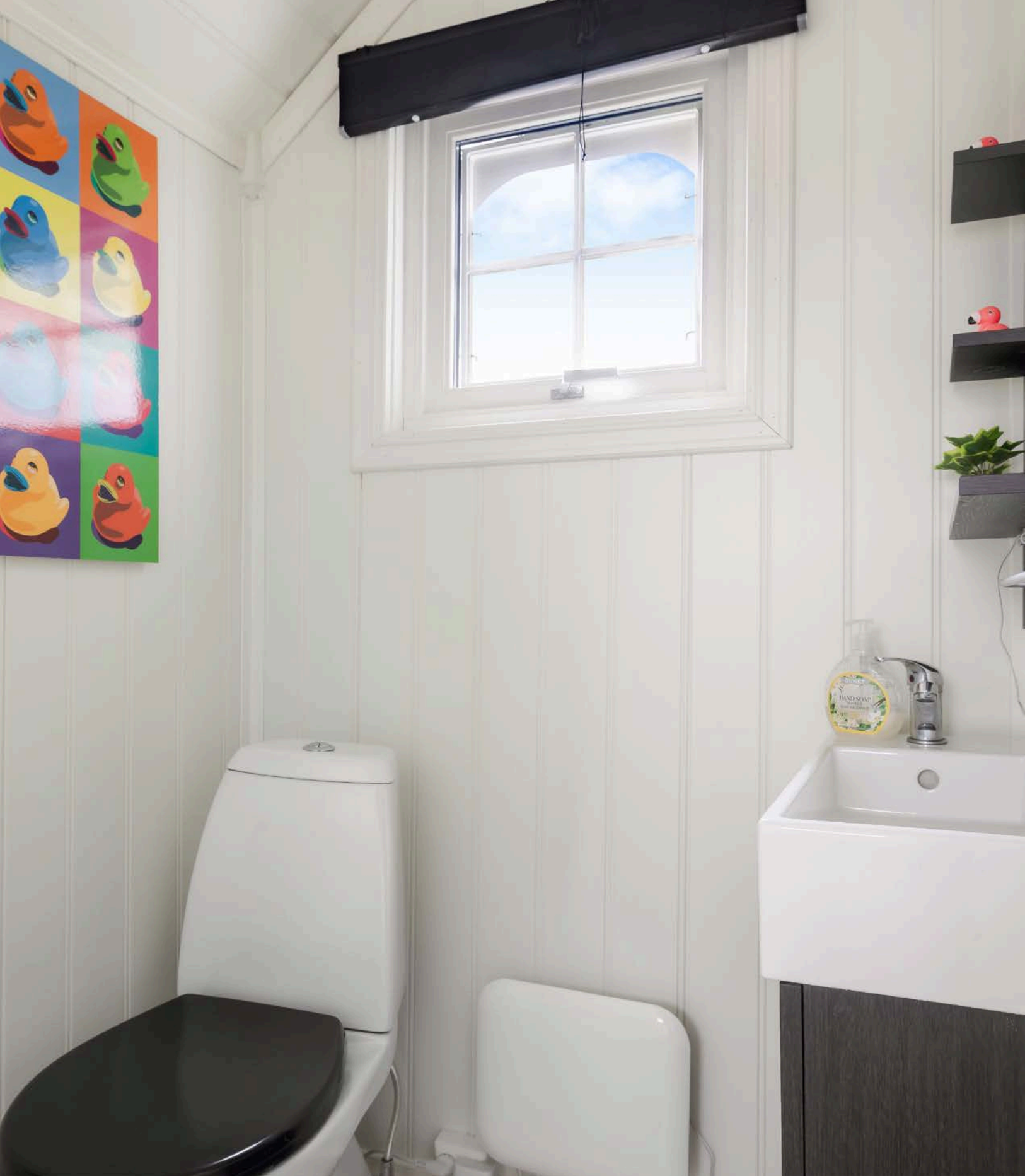
Toalettrom med laminatgulv, panelplater på vegger og panel i himling. Rommet er utstyrt med gulvstående toalett og vegghengt servant.
