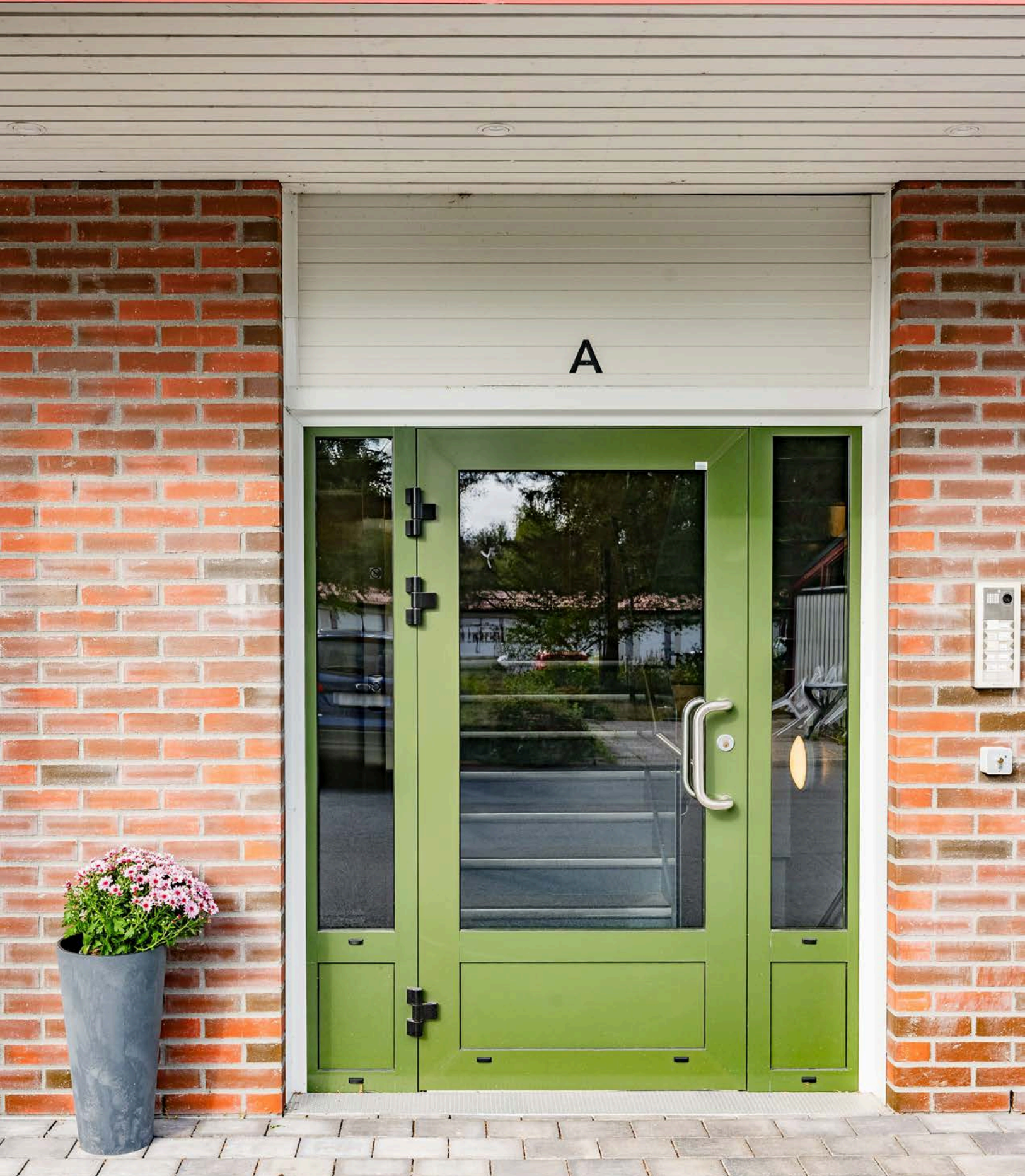
Overbygget inngangsparti med belegningsstein og calling-anlegg.
