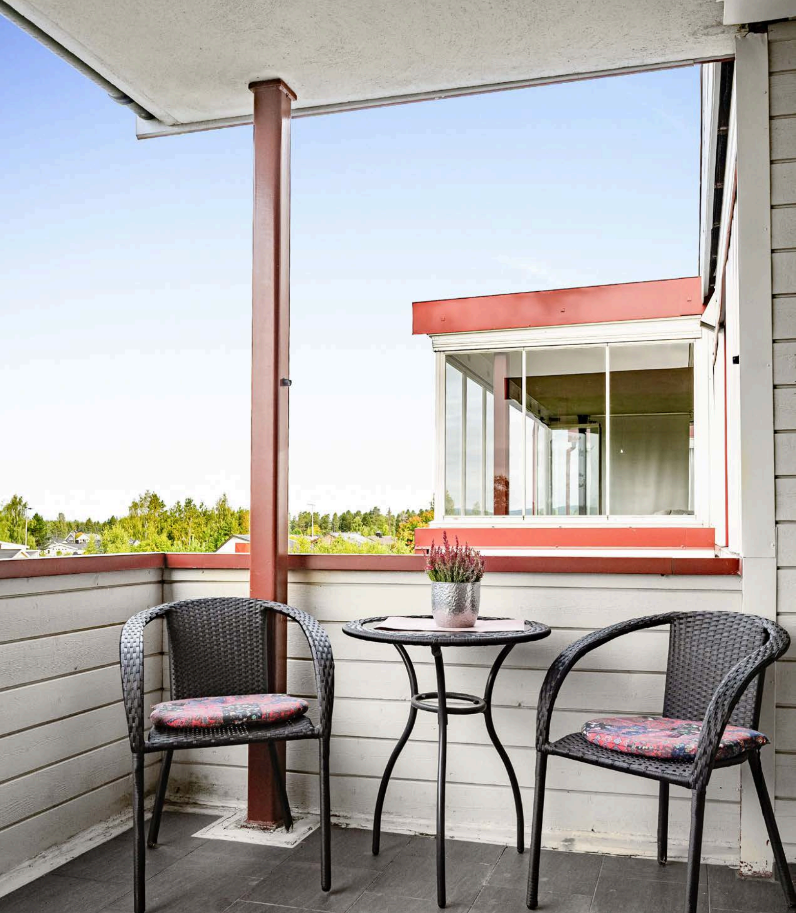
Balkongen er overbygget, har flislagt gulv og god plass til sittegrupper etter eget ønske og behov.
