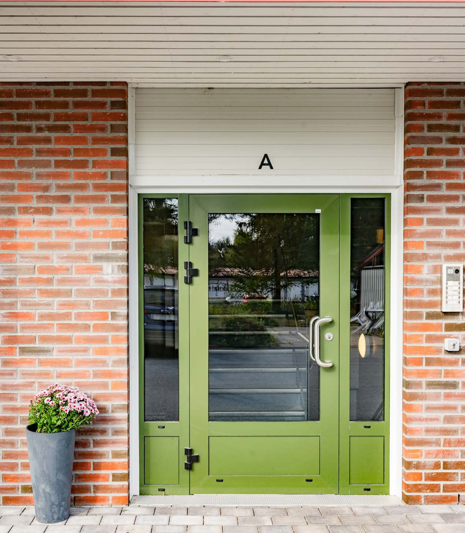
Overbygget inngangsparti med belegningsstein og calling-anlegg.
