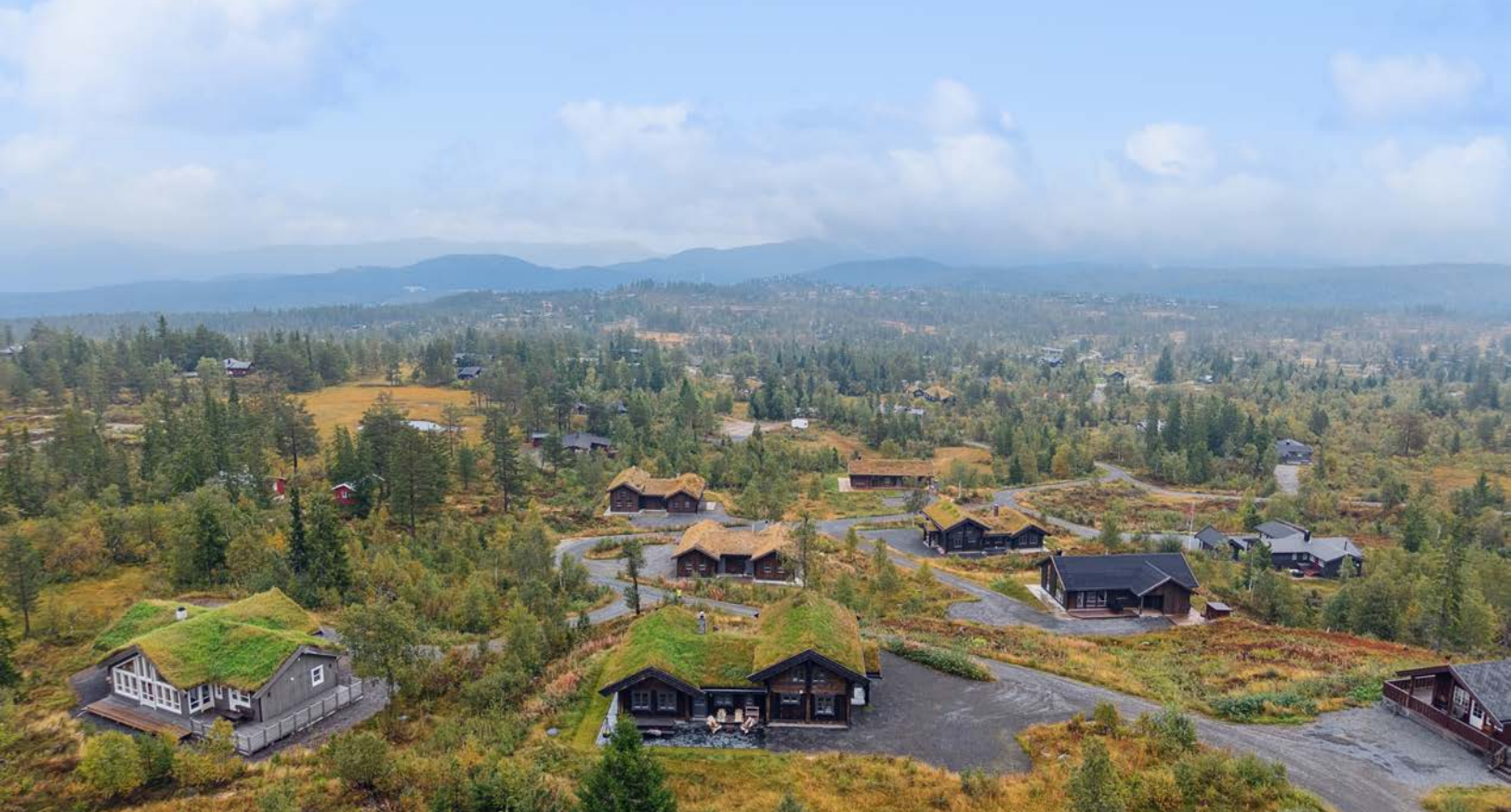
Bakkansetervegen 54 ligger i den idylliske bygda Lampeland, som tilhører Flesberg kommune i Buskerud fylke.
