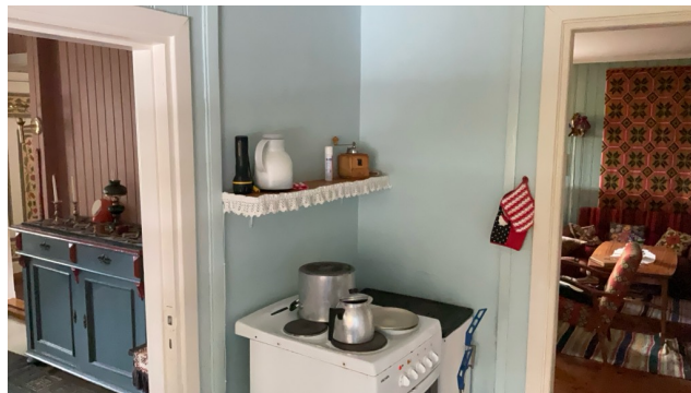
Ingen ventilator ved kokesone.
