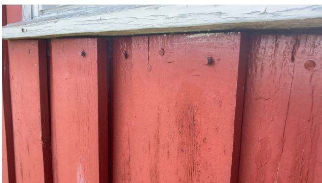
Eksempel på at spik har trekt seg ut.
