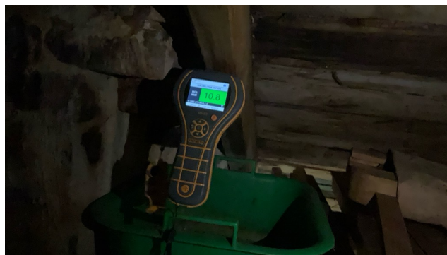
Fuktsøk med pigger i treverk der det er fuktskjolder uten unormale resultater
