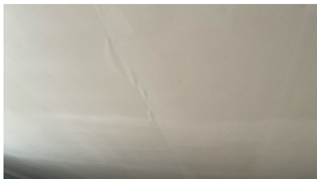
Eksempel på utbulinger/bobler i himling.
