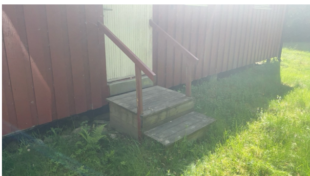
Trapp ved inngangsparti.
