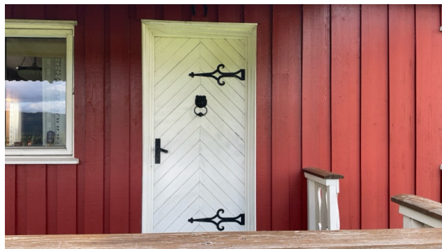
Dør ut til terrasse.
