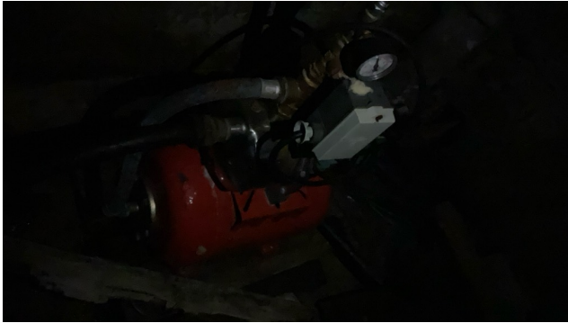
Pumpe som pumper brønnvann.
