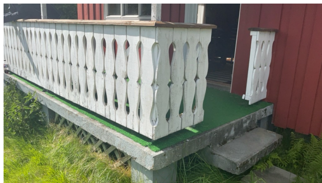
Rekkverk på terrasse.
