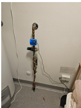
Bilde av tilstøtende vegg til baderommet
