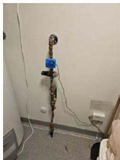
Bilde av tilstøtende vegg til baderommet
