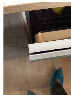
Manglende foring mellom skap.
