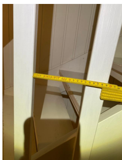
Åpninger på ca. 14cm. Åpninger skal iht. forskrift ikke overstige 10cm.
