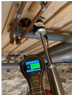
Bilde fra fuktmåling i konstruksjonen.
