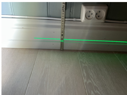
Etasjeskillet er kontrollert med nivelleringslaser.
