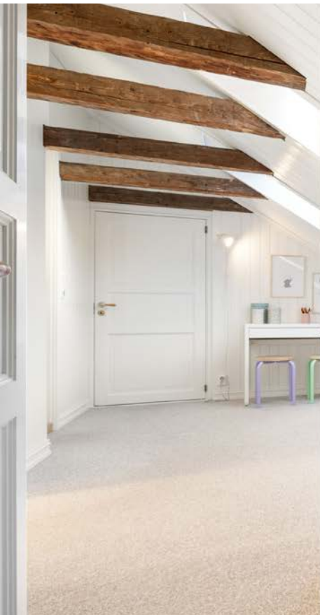
Rom i loftetasjen innredet og brukt som soverom. Rommet har ikke stort nok vindu til at det tilfredsstillers krav om lysinnslipp og rømningsvei.
