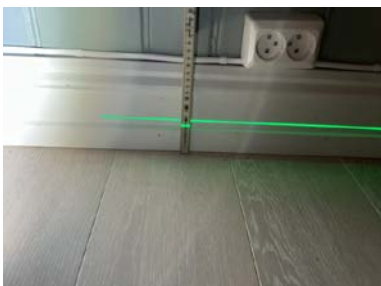
Etasjeskillet er kontrollert med nivelleringslaser.
