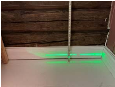
Etasjeskillet er kontrollert med nivelleringslaser.
