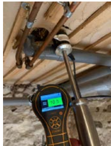
Bilde fra fuktmåling i konstruksjonen.
