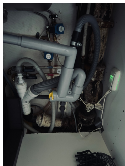
Rør-opplegg og stoppekraner i kjøkkenet.
