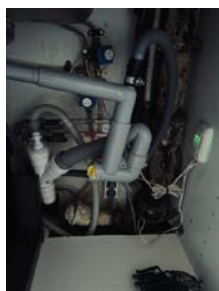
Rør-opplegg og stoppekraner i kjøkken.
