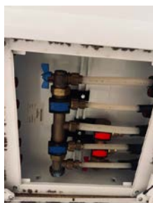
Rør-opplegg og stoppekraner i kjøkken.
