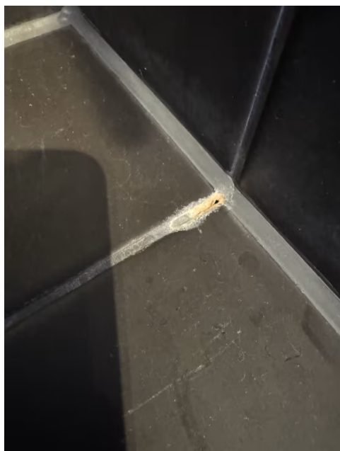
Avvik på flisfuger på veggen.
