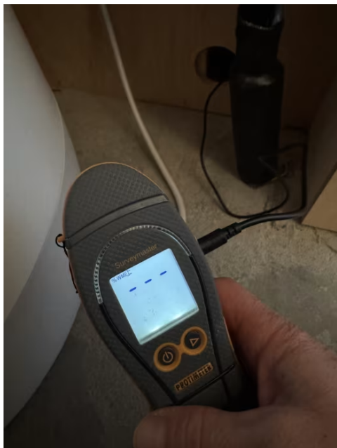
Ingen målt fukt i vegg mot dusjsone.
