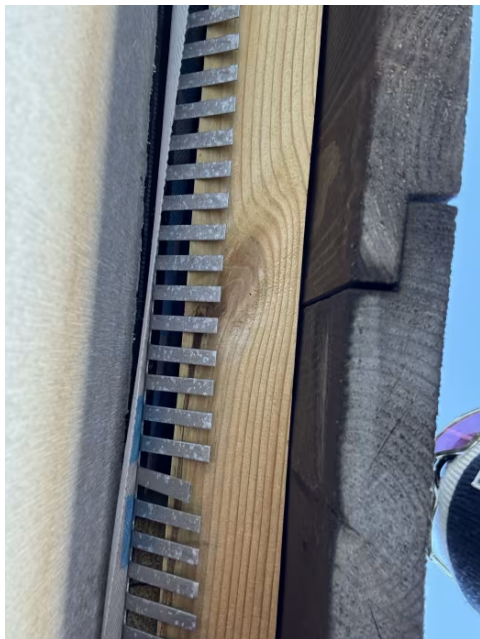
Kledningen er luftet og har musesperre.
