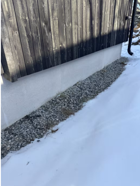
Drenerende terreng inntil grunnmur. Takvann blir ledet tilstrekkelig vekk fra grunnmur.
