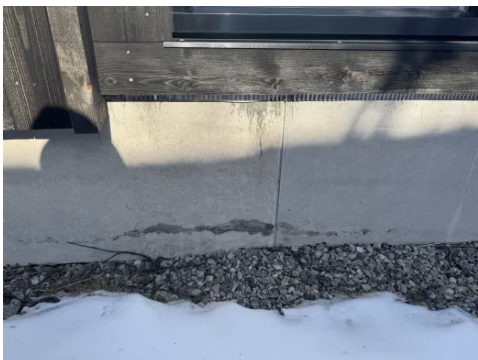
Stabil grunnmur, kum mindre riss og merker etter støping.
