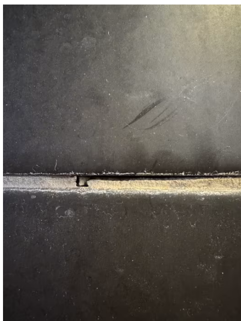
Avvik på flisfuger på veggen.
