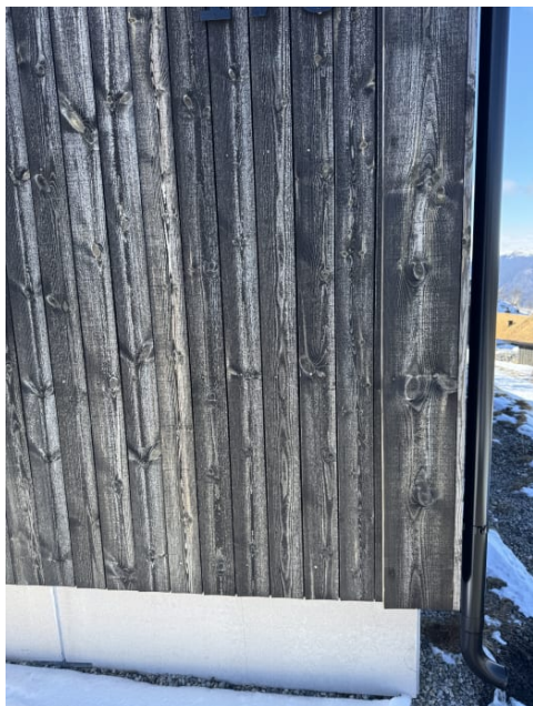
Stort sett hele og fungerende fasader.
