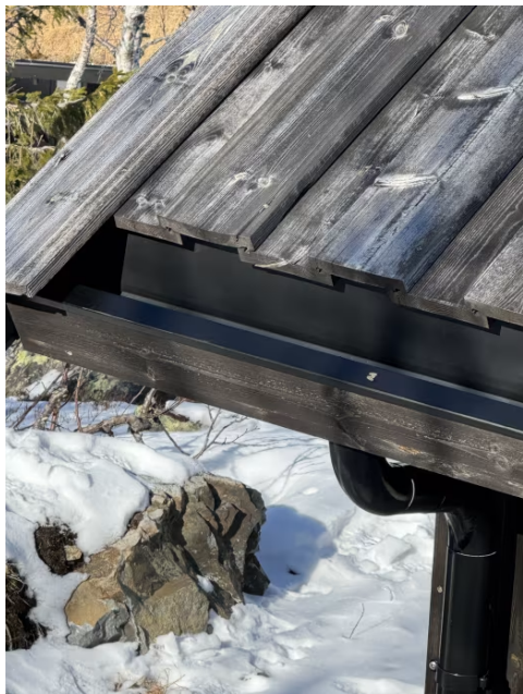
Takrenner av metall integrert i gesims.
