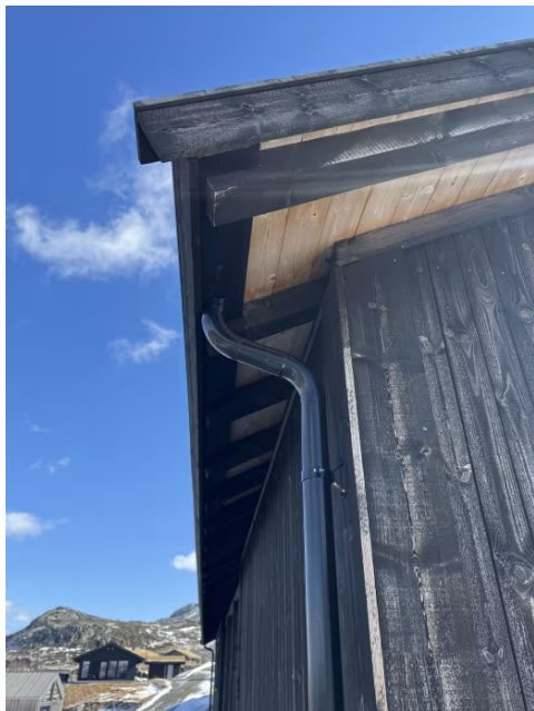
Nedløpsrør av metall.
