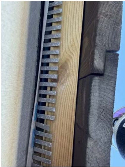
Kledningen er luftet og har musesperre.
