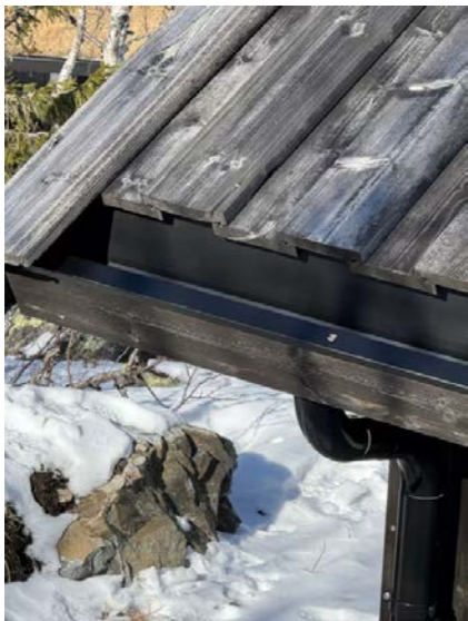
Takrenner av metall integrert i gesims.
