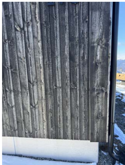
Stort sett hele og fungerende fasader.
