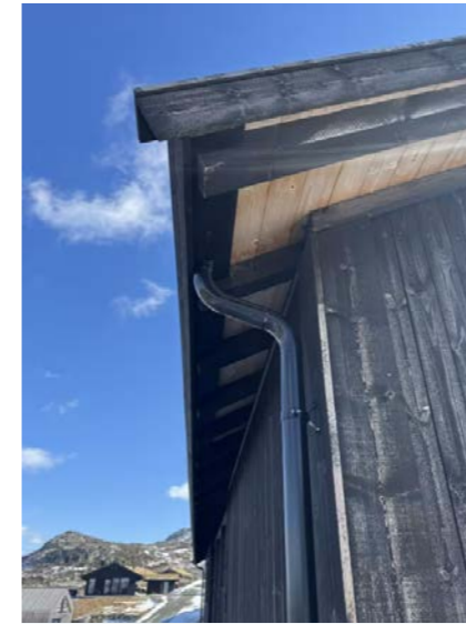
Nedløpsrør av metall.
