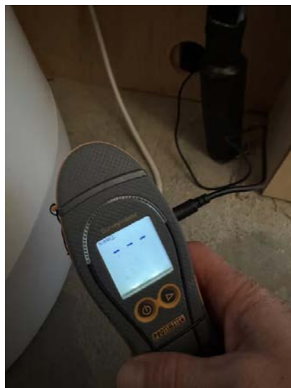
Ingen målt fukt i vegg mot dusjsone.
