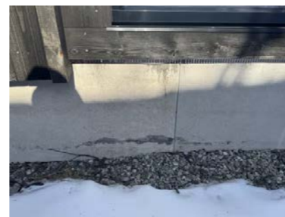
Stabil grunnmur, kum mindre riss og merker etter støping.
