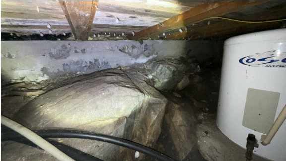
Del av grunnmur.
