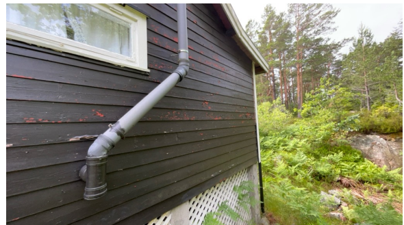
Del av vegg.
