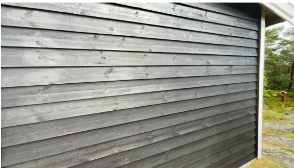
Del av vegg.
