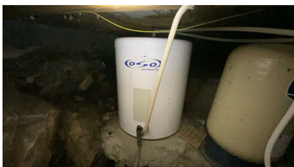
Varmtvannstank.
