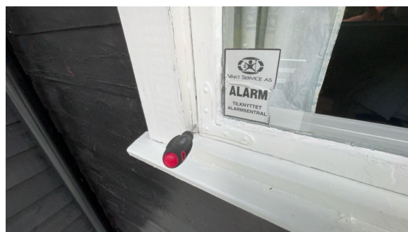
Stikkontroll på vinduer er utført.
