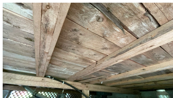
Del av etasjeskille sett fra undersiden.
