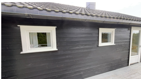
Eksempel på vindu i yttervegg.
