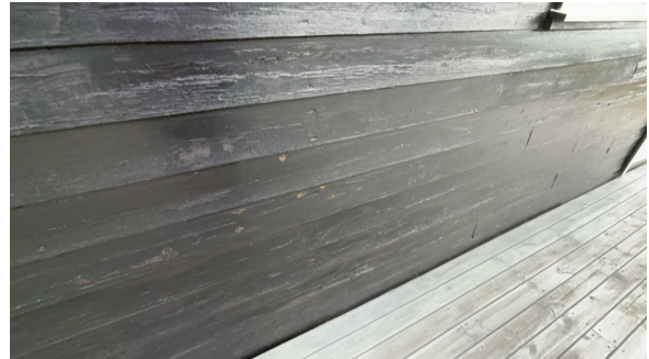
Del av vegg.
