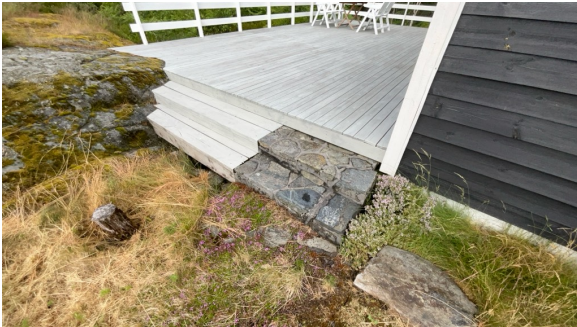
Trapp opp til terrasse.
