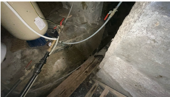
Del av rom under terreng.
