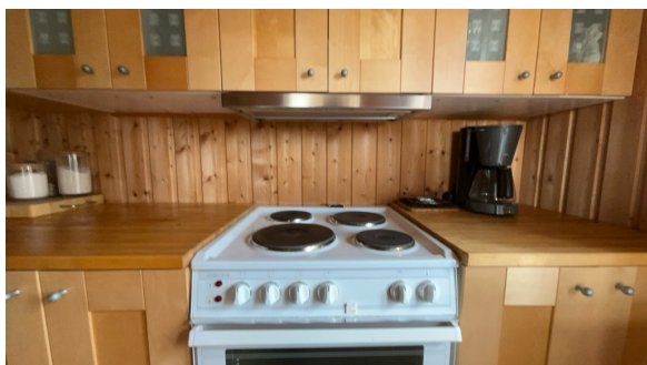
Montert avtrekk over komfyr.
