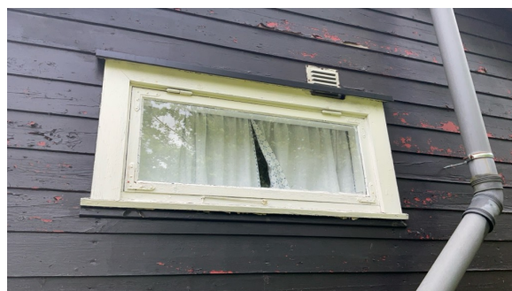
Eksempel på vindu i yttervegg.
