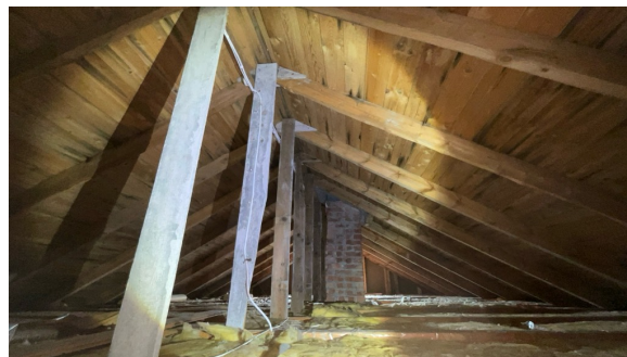
Del av takkonstruksjon, sett fra loft.
