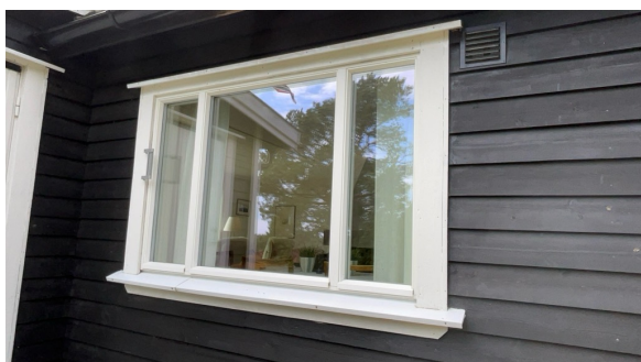
Eksempel på vindu i yttervegg.
