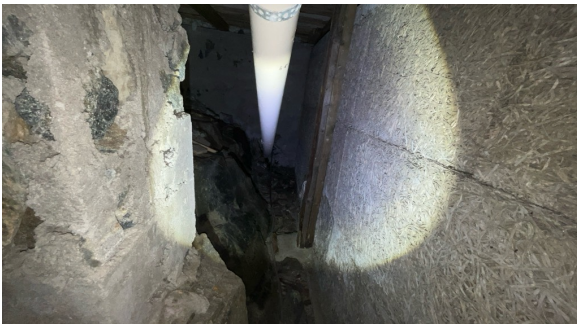
Del av grunnmur.
