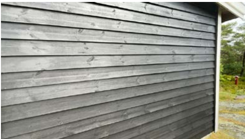
Del av vegg.
