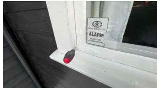
Stikk kontroll på vinduer er utført.
