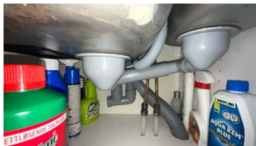
Del av rør til avløp.
