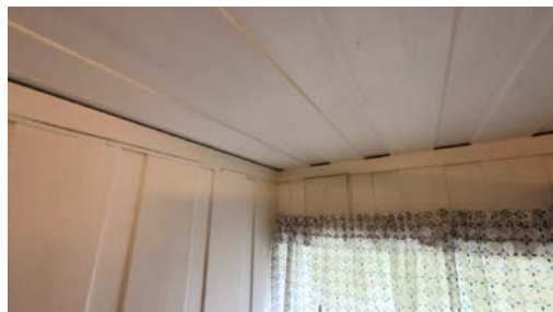
Del av vegg - tak.
