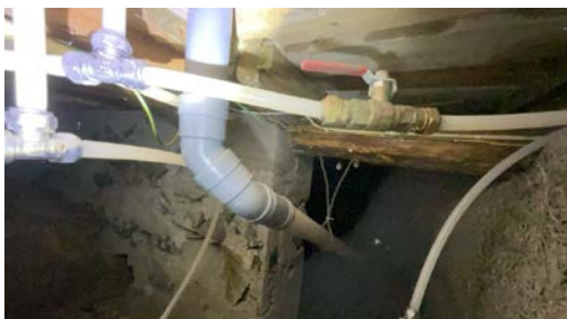
Del av rør til avløp.
