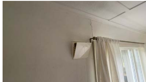
Eksempel på montert ventil i vegg.
