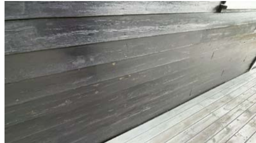
Del av vegg.
