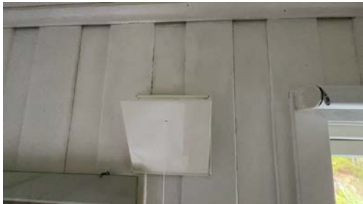
Eksempel på montert ventil i vegg.
