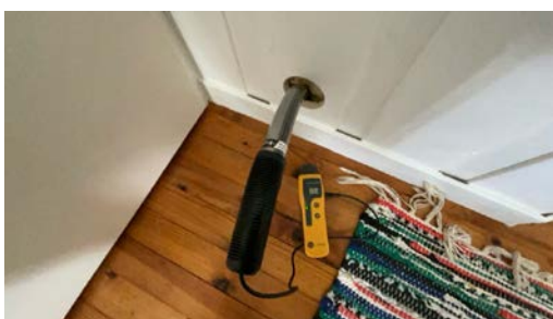
Hull for kontroll av fukt.
