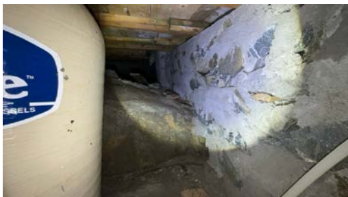
Del av krypkjeller.
