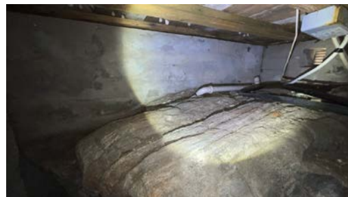
Del av krypkjeller.
