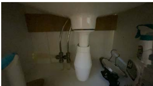
Del av rør til avløp.
