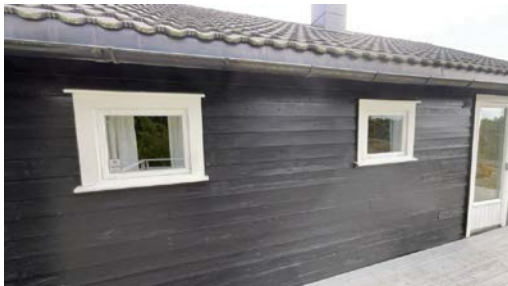
Eksempel på vindu i yttervegg.
