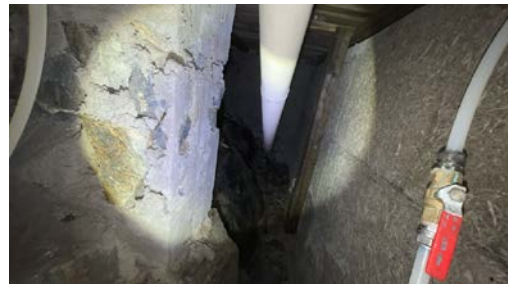
Del av krypkjeller.
