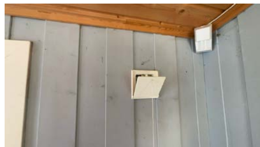
Eksempel på montert ventil i vegg.
