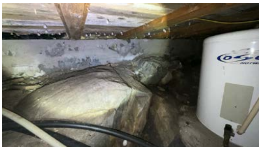
Del av grunnmur.
