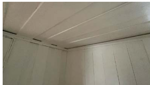
Del av vegg - tak.
