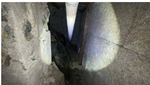
Del av grunnmur.
