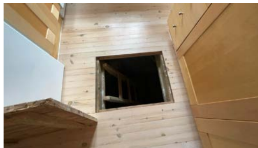
Luke i gulv ned til rom under terreng og krypkjeller.
