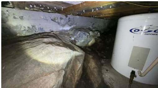
Del av krypkjeller.
