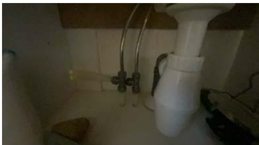
Del av rør til vann.
