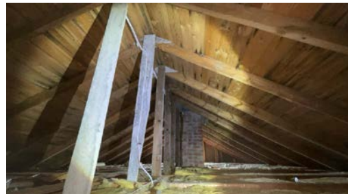
Del av takkonstruksjon, sett fra loft.
