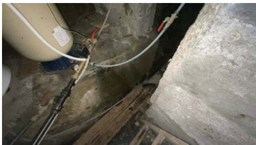
Del av rom under terreng.
