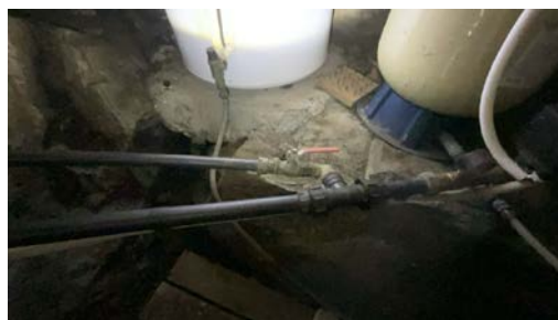
Del av rør til vann.
