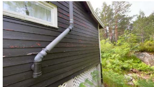
Del av vegg.
