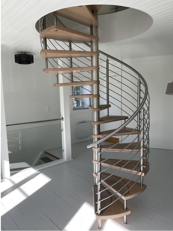
Vindel-trapp. Denne tilfredsstiller ikke krav som eneste internt trapp i en bolig.
