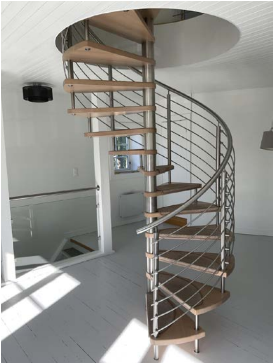
Vindel-trapp. Denne tilfredsstiller ikke krav som eneste interntrepp i en bolig.
