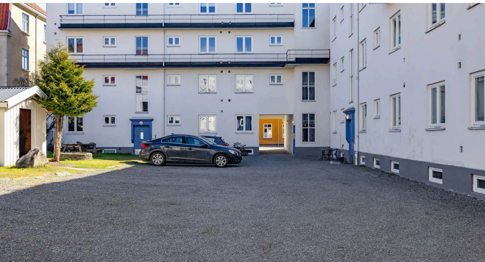
Gruset gårdsplass med 12 parkeringsplasser. Plassene fordeles etter ventelisteprinsippet.
