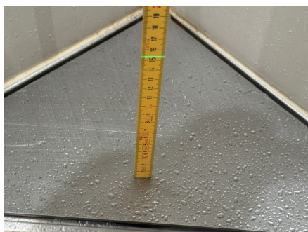
Fallforhold ca. 153 mm topp slukrist i dusjsone
