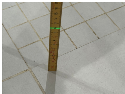
Fallforhold ca. 120 mm overkant gulv ved dusjsone
