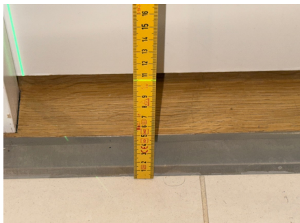
Fallforhold ca. 105 mm overkant gulv ved terskel
