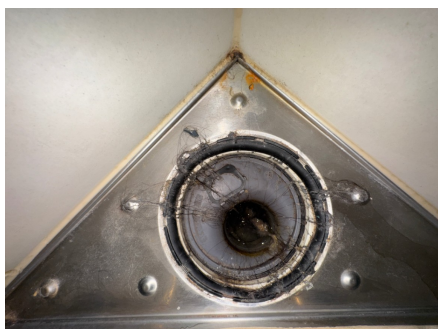
Hjørnesluk i dusjsone
