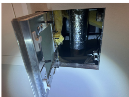
Inspeksjonslukke våtromskabin
