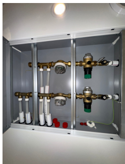
Inspeksjonsluke i himling på bad/wc
