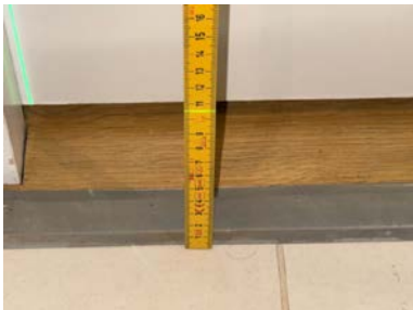
Fallforhold ca. 105 mm overkant gulv ved terskel
