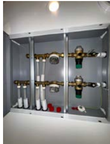
Inspeksjonsluke i himling på bad/wc
