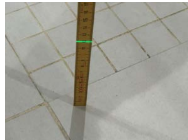
Fallforhold ca. 120 mm overkant gulv ved dusjsone
