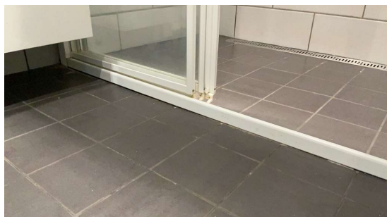
Dusjkyvedør med ramme på gulv, som hindrer evt. lekkasjevann utenfor dusjen å renne til sluk.
