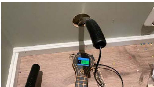
Ingen fuktutslag registrert ved fuktmåling i vegg
