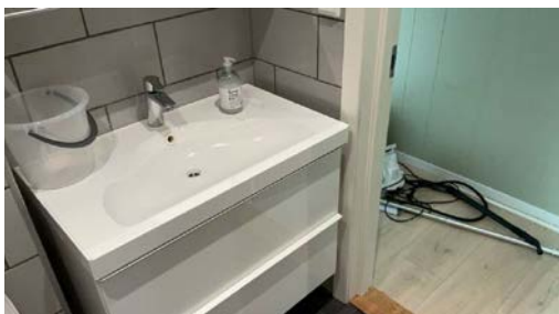
Bildet viser at døren er i våtsonen av vasken.
