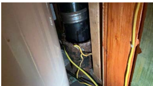
Støpejernsrør rett over gulv i kjeller og ned i bakken
