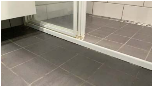
Dusjskyvedør med ramme på gulv, som hindrer evt. lekkasjevann utenfor dusjen å renne til sluk.
