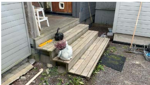
Mangler rekkverk.
