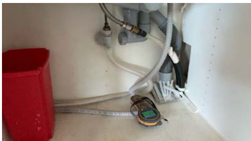
Ingen fuktighet registrert ved fuktsøk
