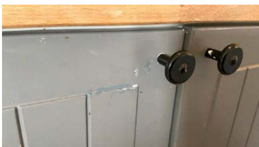
Overflateskader
