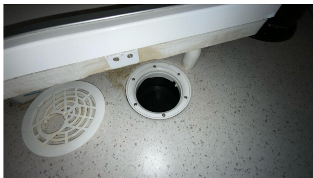
Kontroll av sluk.
