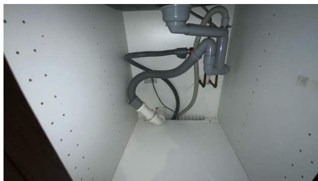
Besiktigelse av røropplegg.
