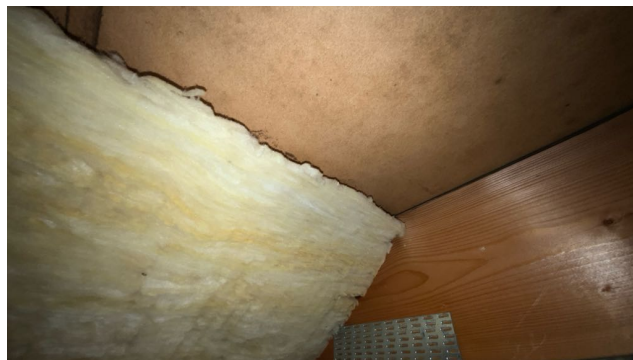
Minimalt med luftespalter på isolert del.
