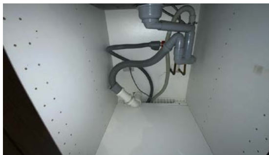
Besiktigelse av rørøpplagg.
