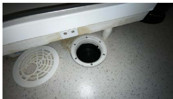
Kontroll av sluk.
