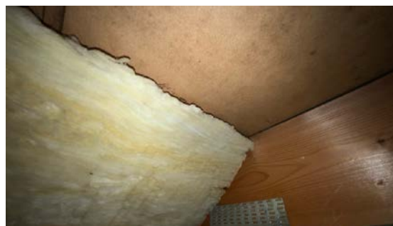
Minimalt med luftespalter på isolert del.
