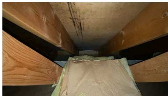
Kontroll av undertak.
