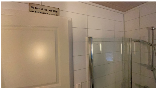
Innvendig dør i våtsone for dusjnise.
