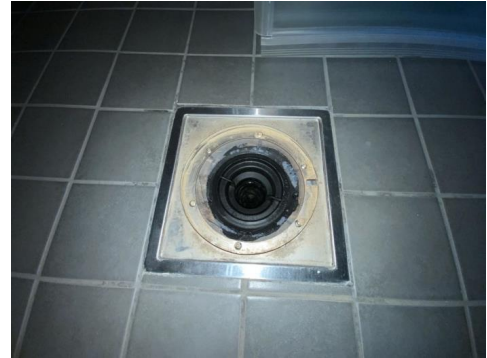
Kontroll av sluk.
