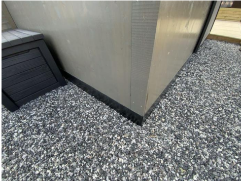
Begrenset lufting av ytre veggoverflater.
