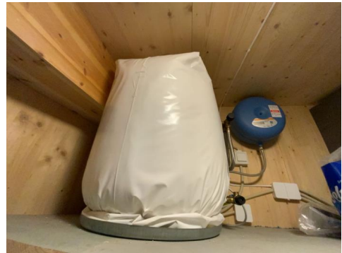
Besiktigelse av bereder.
