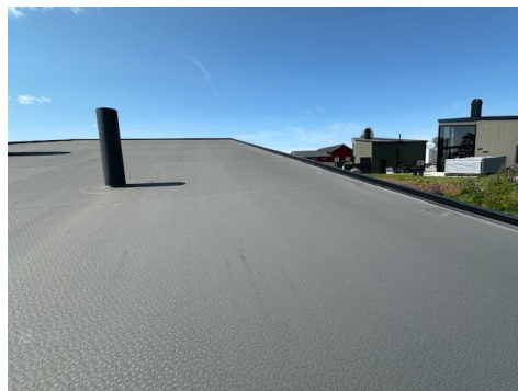
Besiktigelse av taktekke.
