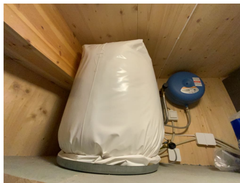
Besiktigelse av bereder.
