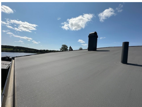
Besiktigelse av taktekke.
