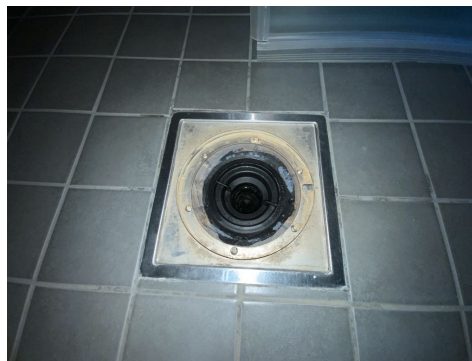
Kontroll av sluk.
