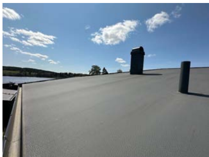
Besiktigelse av taktekke.
