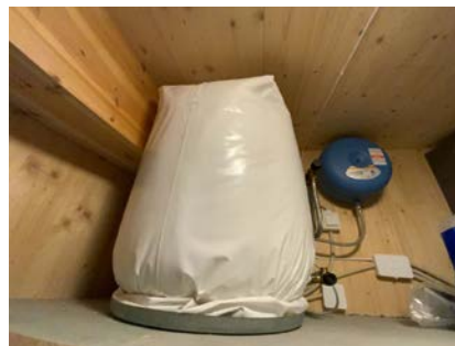
Besiktigelse av bereder.
