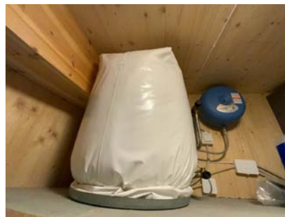
Besiktigelse av bereder.
