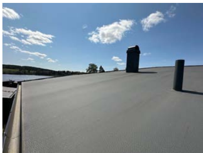
Besiktigelse av taktekke.
