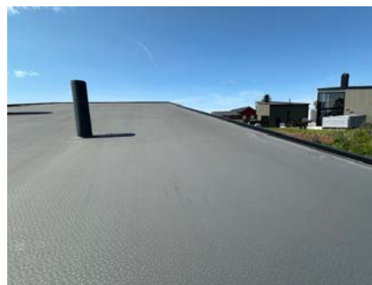
Besiktigelse av taktekke.
