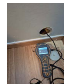
Ikke målt noe unormalt med fukt i kjellerstue.
