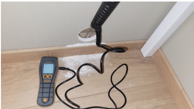
Hulltaking og fuktmåling.
