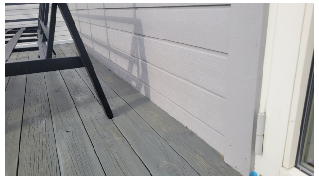
Terrassebord avsluttet mot trepanel.
