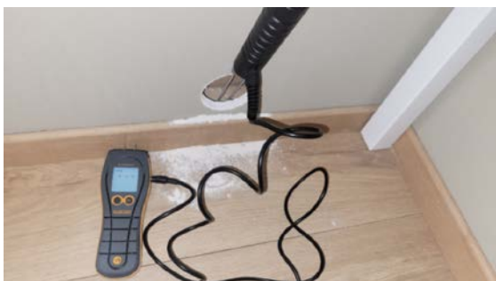
Hulltaking og fuktmåling.
