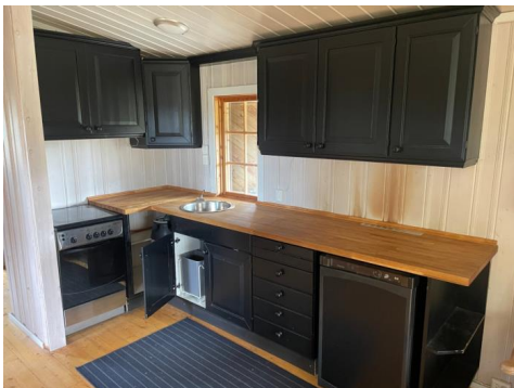
Antydning til varmegang i trepanel.
