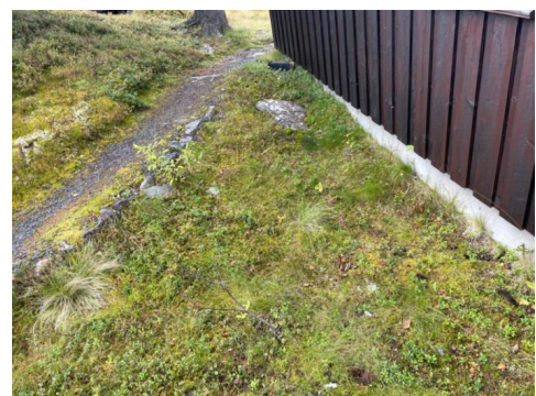
Området med flatt terreng mot grunnmur.
