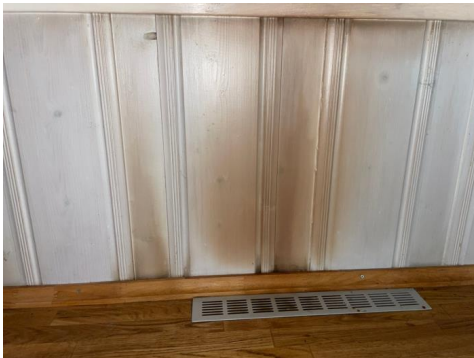
Antydning til varmegang i trepanel.
