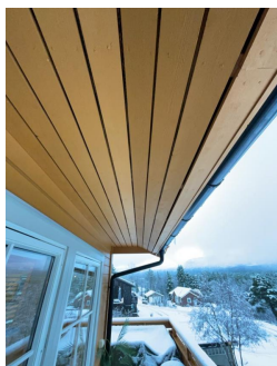
Synlige luftespalter i raftekasse ved overgang tak/vegg
