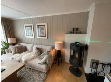
1. etasje Plassering av laser ved kontroll av stue. Det er målt 7 mm høydeforskjell gjennom rommet. TG 1
