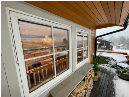
Vinduer på kjøkken
