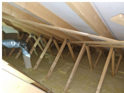
Oversikt kryploft. Lagt til grunn pustende undertak ved vurdering av ventilering
