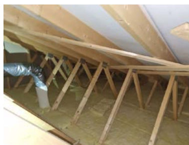
Oversikt kryploft. Lagt til grunn pustende undertak ved vurdering av ventilering
