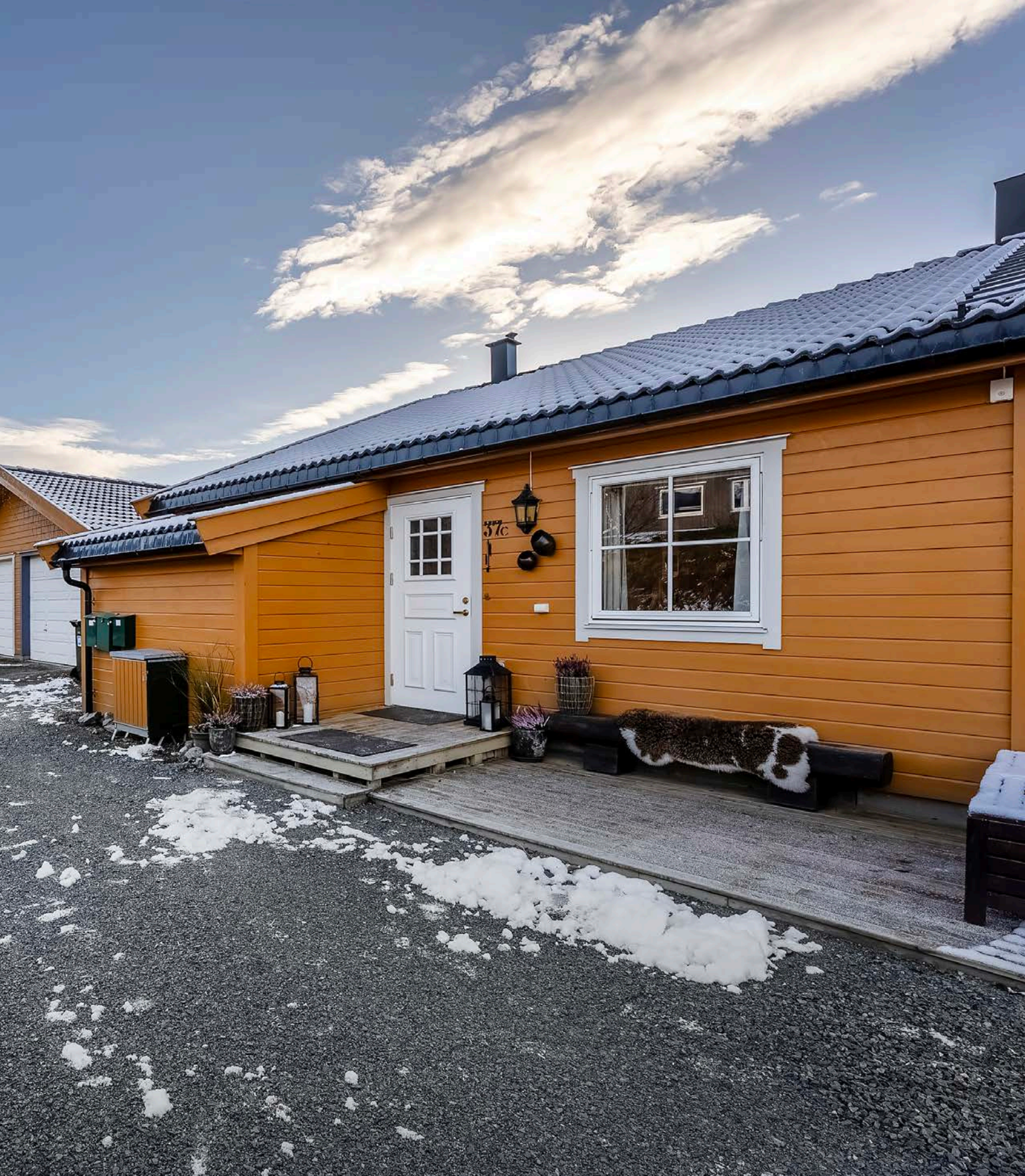
Inngangsparti med terrasse og utvendig bod
