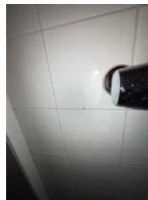
Sprukket flis i hjørne i våtsone inne i dusj. Ikke tegn til andre skader ved beforingen
