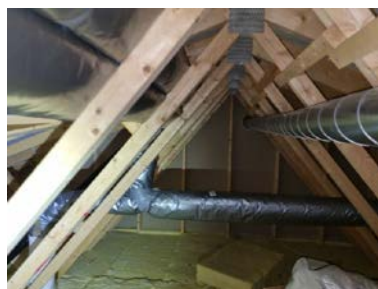
Oversikt kryploft. Lagt til grunn pustende undertak ved vurdering av ventilering
