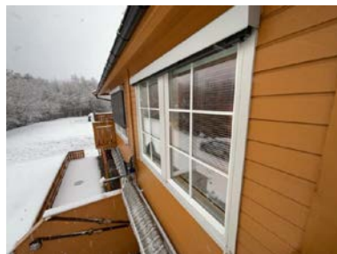
Vinduer på stue har utvendige persienner som er manuelle.
