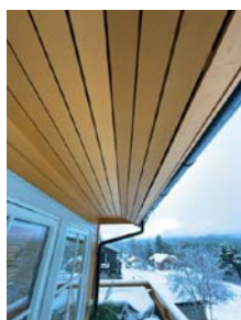
Synlige luftespalter i raftekasse ved overgang tak/vegg
