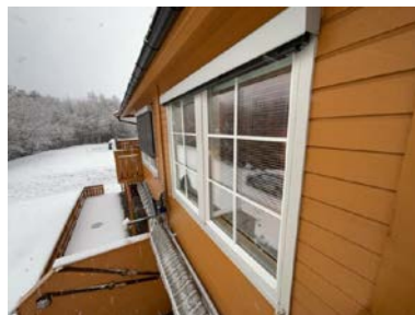
Vinduer på stue har utvendige persienner som er manuelle.
