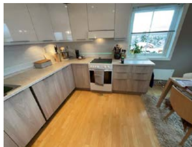
1. etasje Plassering av laser ved kontroll av kjøkken. Det er målt 7 mm høydeforskjell gjennom rommet. TG 1
