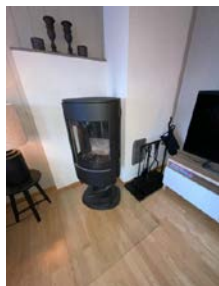
Vedovn på stue, steinplate under sotluke på gulvet
