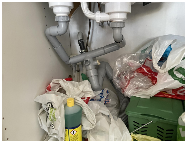
Løse deler og motfall på avløpsvann fra sidekum.
