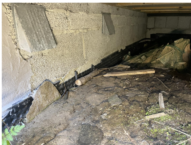
Det er motfall på terrenget, altså fall inn mot bygningen.
