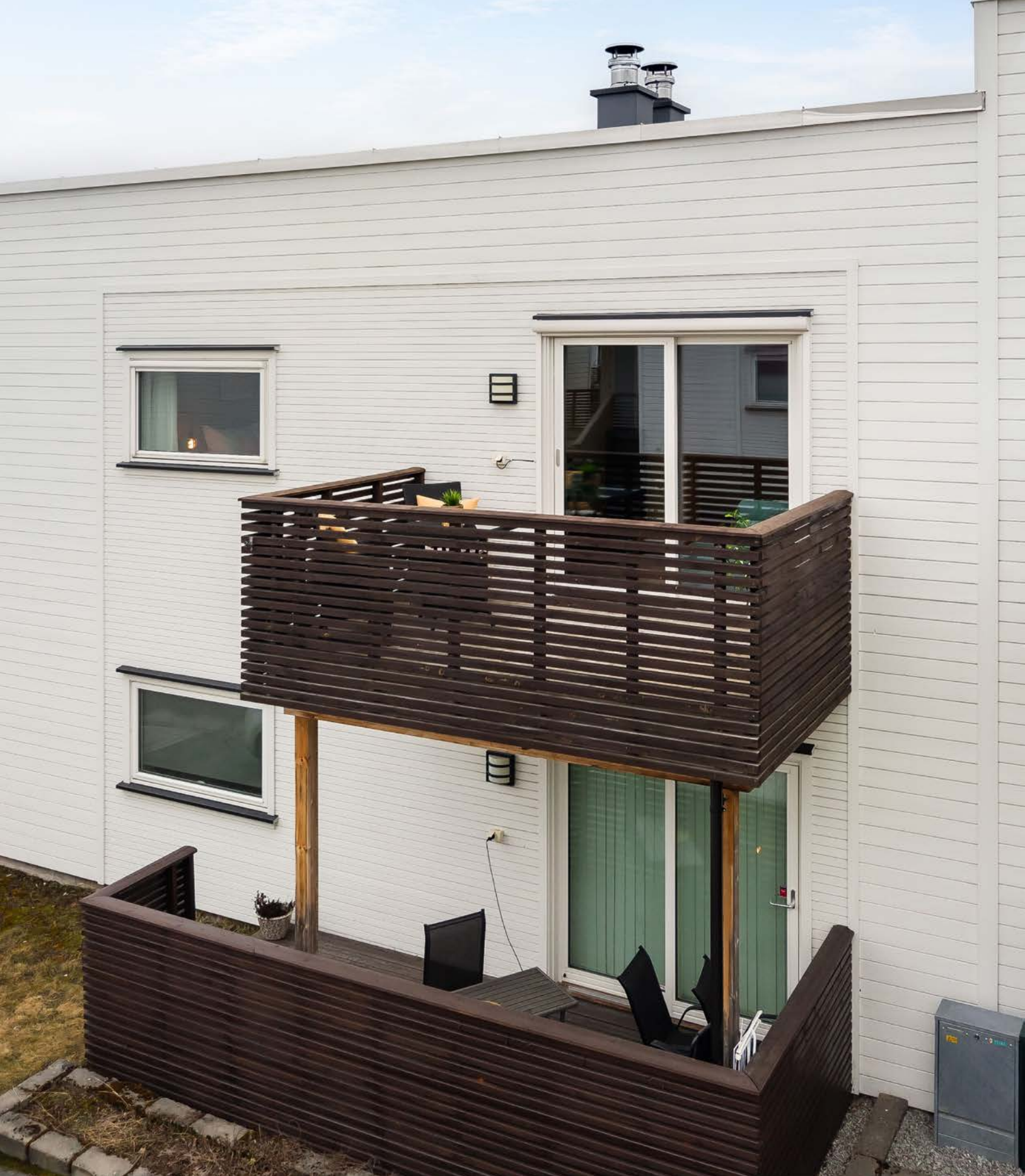
Balkongen utenfor stua. Det er montert utvendig screens på døra og soveromsvinduet.
