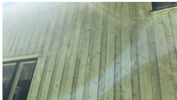
Det er oppsprukket trevirke/trepaneler, det er behov for vask og overflatebehandling.
