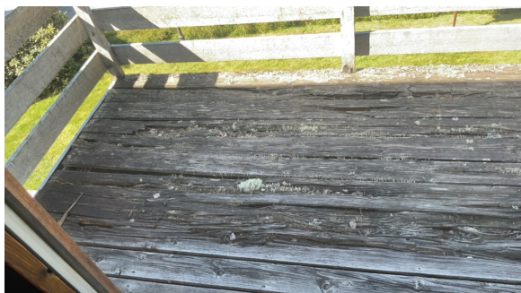
Det er påvist råteskader i konstruksjonen på terrasse i 2. etasje.
