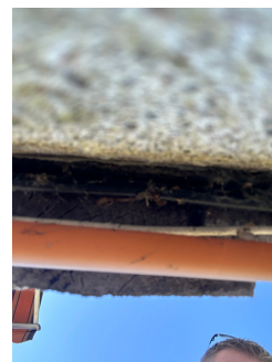
Det er oppsprukket trevirke/trepaneler, det er behov for vask og overflatebehandling.
