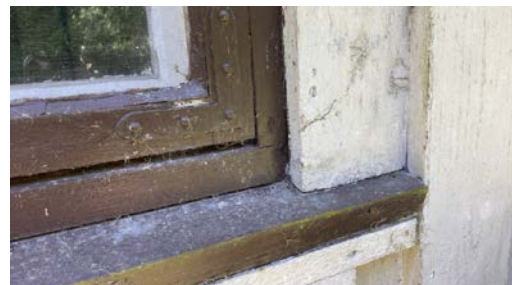
Vindusomramming står i kontakt med underbeslaget og trekker dermed opp fukt/vann som reduserer levetiden på sidebordene.
