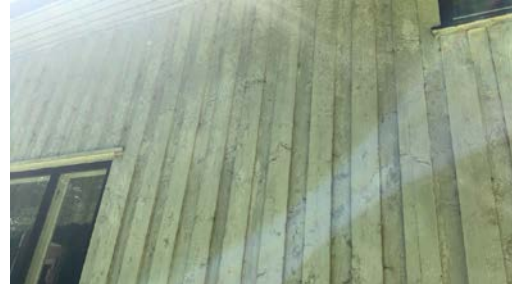
Det er oppsprukket trevirke/trepener, det er behov for vask og overflatebehandling.
