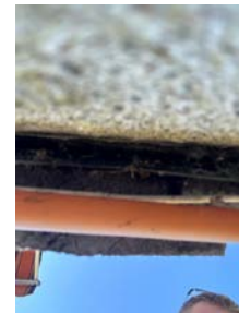
Det er oppsprukket trevirke/trepener, det er behov for vask og overflatebehandling.
