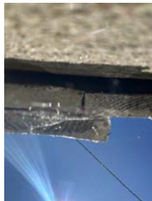
Det er ingen eller liten lufting i nedre kant av kledning mot grunnmur.
