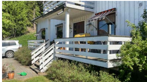
Rekkverket er for lavt i forhold til dagens krav til rekkverkshøyder. Åpninger i rekkverk er ikke i henhold til krav i dagens forskrifter.
