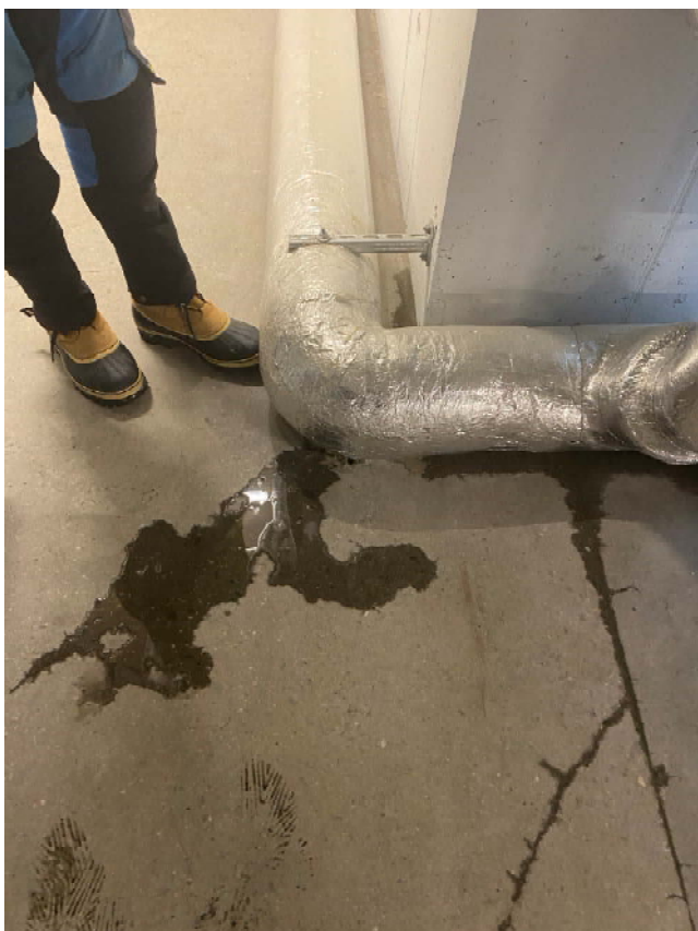
Bilde 4 Riss teknisk-/sprinklerrom. Riss ved vinkelendringer (Fastholding)
