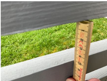
Åpninger i rekkverk er ikke i henhold til krav i dagens forskrifter.
