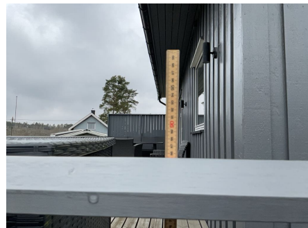
Rekkverket er for lavt i forhold til dagens krav til rekkverkshøyder.
