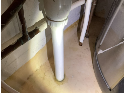
Utilfredstillende tetting ved rørgjennomganger
