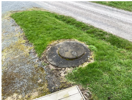
Kum til vannpumpe.
